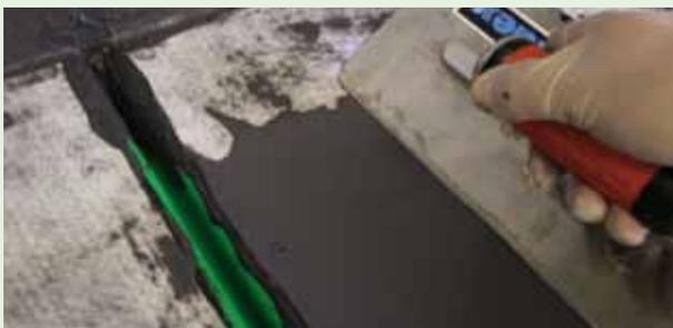
Pendant l'application de la deuxième couche d'UNOLASTIC, recouvrir soigneusement toute l'armature en RINFOTEX PLUS, sur une épaisseur totale de 3 mm.
