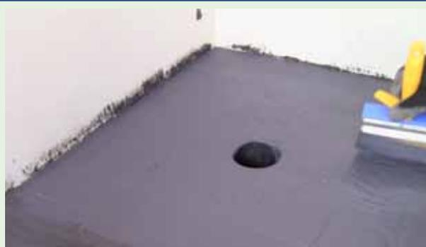
Recouvrir soigneusement le RINFOTEX PLUS et toute la surface d'UNOLASTIC sur une épaisseur totale de 3 mm.
