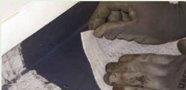
Continuer l'imperméabilisation en superposant un morceau de RINFOTEX PLUS sur environ 10 cm.
