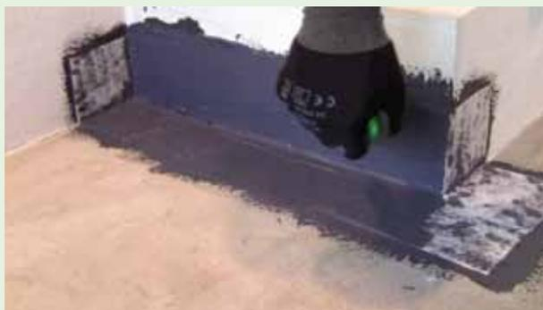
Appliquer une couche abondante (1-1,5 mm) d'UNOLASTIC à proximité des joints, au sol et sur les murs, sur une largeur de 10 cm.
