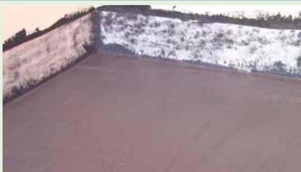
Après avoir imperméabilisé soigneusement tous les joints périphériques, appliquer une couche uniforme et abondante d'UNOLASTIC sur le plan horizontal, sur une épaisseur de 1-1,5 mm.
