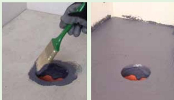
Appliquer une couche abondante (1-1,5 mm) d'UNOLASTIC sur la surface où devra être insérée l'évacuation.
