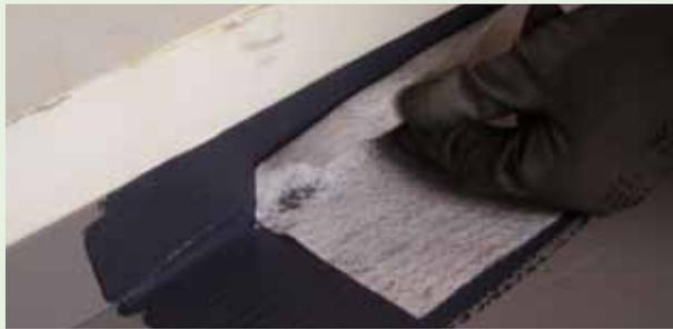
Fixer le RINFOTEX PLUS sur l'UNOLASTIC frais en suivant le joint entre le mur et le sol.
