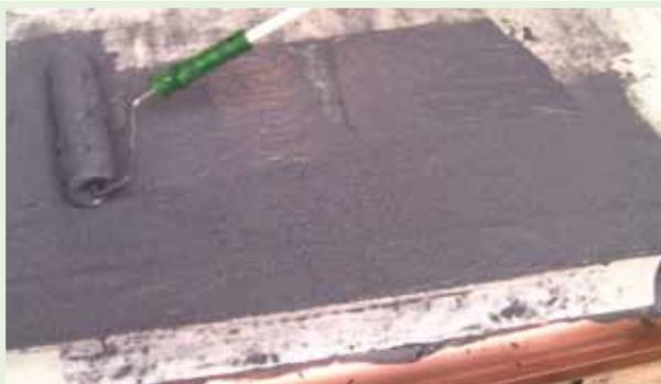
Appliquer l'UNOLASTIC de manière à recouvrir soigneusement le RINFOTEX PLUS, sur une épaisseur totale de 3 mm.
