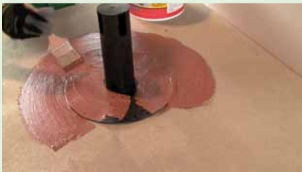
Appliquer une couche abondante (1-1,5 mm) d'UNOLASTIC sur la surface de l'aérateur et sur 10 cm de plus sur le support.
