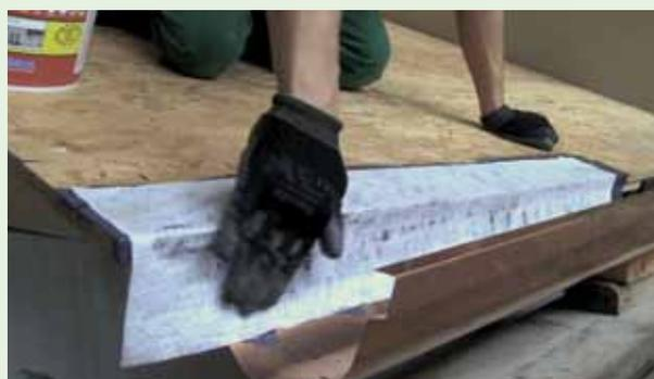
Appliquer une bande de RINFOTEX PLUS de 20 cm de large sur l'UNOLASTIC encore frais et exercer une pression de manière à garantir le collage total en évitant la formation de plis.
