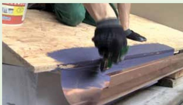
Appliquer une couche abondante (1-1,5 mm) d'UNOLASTIC sur la surface d'angle entre le toit et la gouttière sur une largeur de 10 cm.
