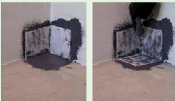
Appliquer UNOLASTIC de manière à recouvrir la surface horizontale. Appliquer la bande de RINFOTEX PLUS sur l'UNOLASTIC encore frais et exercer une pression de manière à garantir le collage total en évitant la formation de plis.
