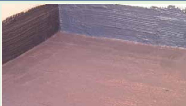
Recouvrir soigneusement le RINFOTEX PLUS d'UNOLASTIC sur une épaisseur totale de 3 mm.
