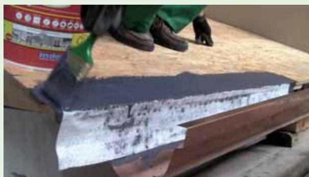
Recouvrir soigneusement le RINFOTEX PLUS avec une couche d'UNOLASTIC sur une épaisseur totale de 3 mm.
