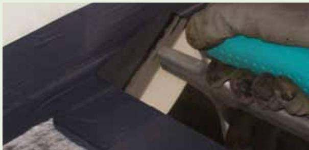
Recouvrir soigneusement le RINFOTEX PLUS avec l'UNOLASTIC.
