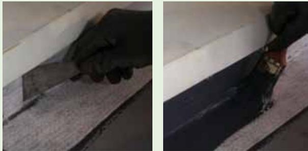
Exercer une forte pression et lisser pour garantir le collage total du RINFOTEX PLUS en évitant la formation de plis dans la bande, et recouvrir en appliquant l'UNOLASTIC sur une épaisseur totale de 3 mm.
