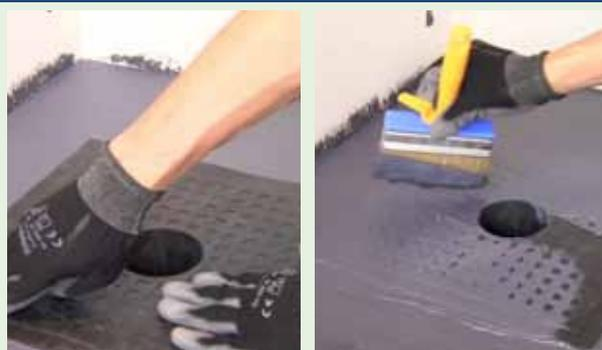
Positionner l'évacuation sur l'UNOLASTIC encore frais. Après avoir bien appuyé dessus pour garantir le collage total, recouvrir la collerette d'UNOLASTIC à raison de 1-1,5 mm d'épaisseur.
