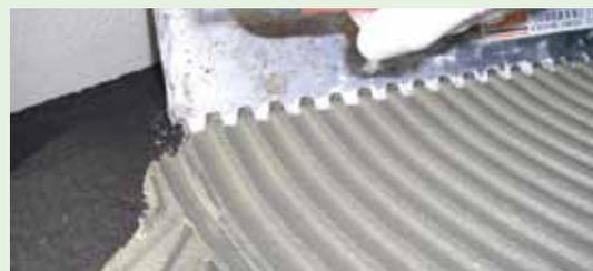
Sur UNOLASTIC, il est possible de poser des carreaux en utilisant les colles C2, S1/S2.
