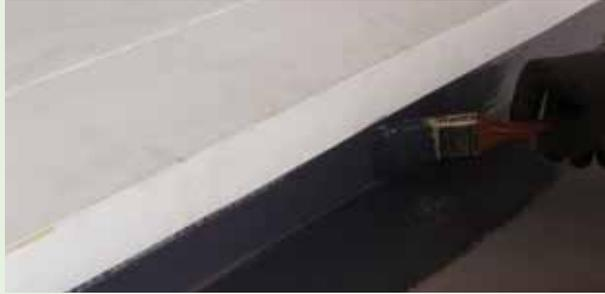
Appliquer une couche abondante (1-1,5 mm) d'UNOLASTIC sur la dalle et sous le seuil sur une longueur et une largeur qui permettront le collage du RINFOTEX PLUS.
