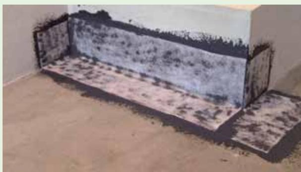
Fixer le RINFOTEX PLUS sur l'imperméabilisant frais en suivant le joint entre le mur et le sol sur toute la périphérie de la surface à imperméabiliser.
