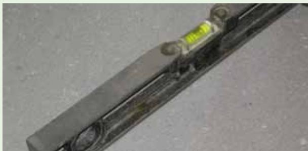
Vérifier la planéité de la dalle et la présence de pentes adéquates pour l'évacuation des eaux de pluie.
