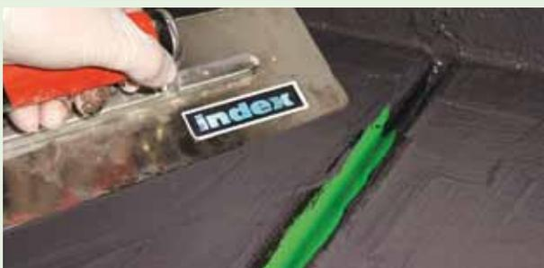
Appliquer l'UNOLASTIC avec une spatule lisse sur une épaisseur d'environ 1-1,5 mm en appuyant pour obtenir la meilleure adhérence possible sur le support. L'épaisseur d'application dépend de la finition superficielle et de la planéité du support.
