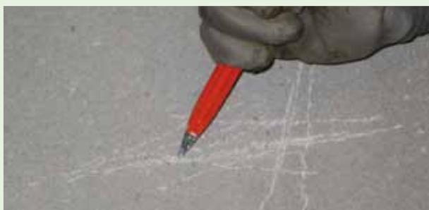
Vérifier la consistance de la surface de la dalle pour garantir l'adhérence maximale de la membrane imperméabilisante.
