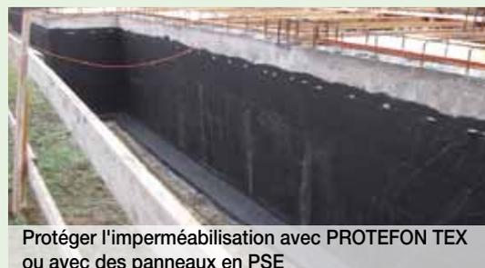
Protéger l'imperméabilisation avec PROTEFON TEX ou avec des panneaux en PSE
