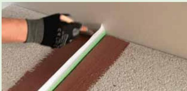
Appliquer UNOLASTIC sur les bords et insérer COVERBAND en forme d'oméga dans le joint.
