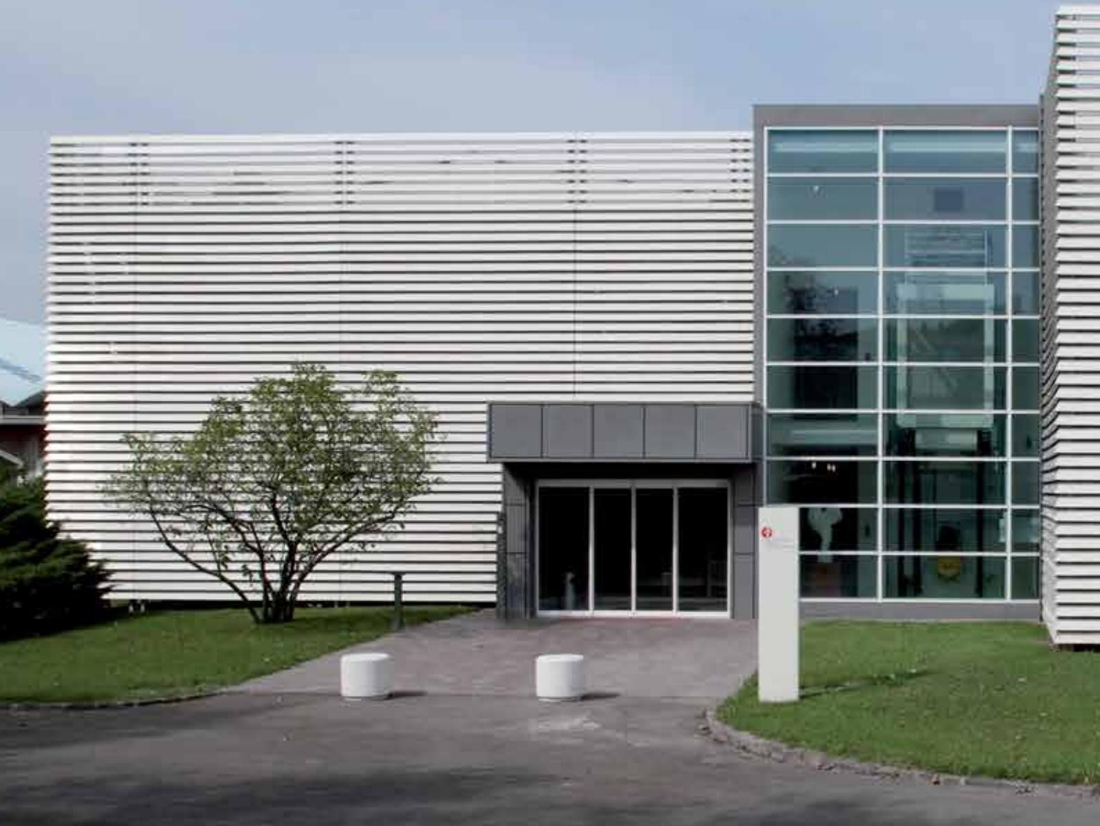
Le brise-soleil est composé d'éléments parallèles opportunément espacés et inclinés qui ont la fonction de protéger les pièces intérieures des rayons directs du soleil sans les priver ni d'air ni de lumière. Le brise-soleil devient aussi un élément de valorisation esthétique, car en brisant la continuité de la façade, il permet de satisfaire les exigences de projet dans des contextes particulièrement sophistiqués et de prestige.
