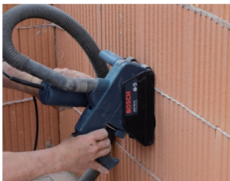
Saignées pour l'installation électrique
