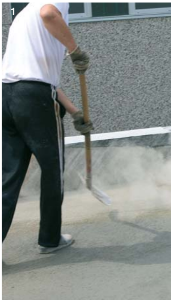
Photo 1) Poudrage sur surfaces horizontales fraîchement coulées - Photo 2) Finition à l'hélicoptère - Photo 3) Phases d'exécution - Photo 4) Maturation humide des surfaces
