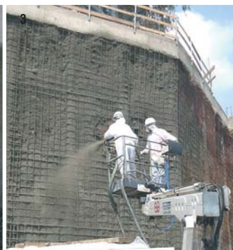
Photo 1) Béton projeté imperméable d'assainissement du profil endommagé d'une galerie ferroviaire - Photo 2 - 3) Béton projeté imperméable contre pieux de parking enterré Photo 4) Croissance cristalline dans le temps véhiculant l'humidité dans les fissurations et porosités résiduelles du béton projeté
