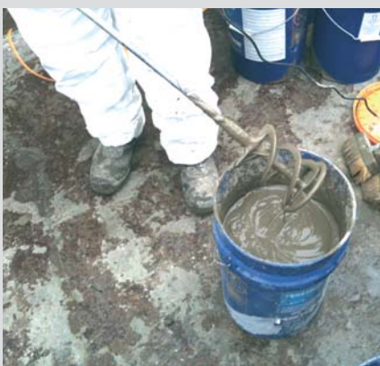
Mélange du Penetron Standard en « coulis » dense et mielleux
