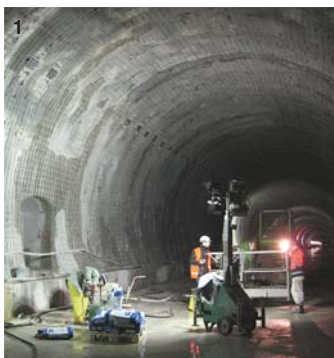
Photo 1) Béton projeté imperméable d'assainissement du profil endommagé d'une galerie ferroviaire - Photo 2 - 3) Béton projeté imperméable contre pieux de parking enterré Photo 4) Croissance cristalline dans le temps véhiculant l'humidité dans les fissurations et porosités résiduelles du béton projeté
