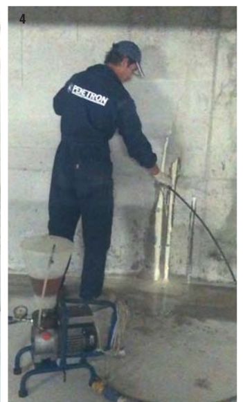
Photo 1) Lésion avec fuite d'eau en poussée hydraulique - Photo 2) Préparation des trous pour les packers d'injection - Photo 3) Fixation des packers étanches dans les trous Photo 4) Injection, au moyen d'une pompe électrique, de la résine hydro-expansive élastique.
