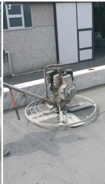
Photo 1) Poudrage sur surfaces horizontales fraîchement coulées - Photo 2) Finition à l'hélicoptère - Photo 3) Phases d'exécution - Photo 4) Maturation humide des surfaces
