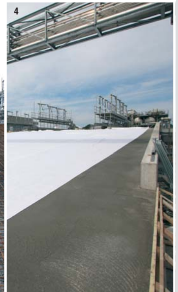
Photo 1) Poudrage sur surfaces horizontales fraîchement coulées - Photo 2) Finition à l'hélicoptère - Photo 3) Phases d'exécution - Photo 4) Maturation humide des surfaces
