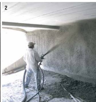
Photo 1) Béton projeté imperméable d'assainissement du profil endommagé d'une galerie ferroviaire - Photo 2 - 3) Béton projeté imperméable contre pieux de parking enterré Photo 4) Croissance cristalline dans le temps véhiculant l'humidité dans les fissurations et porosités résiduelles du béton projeté
