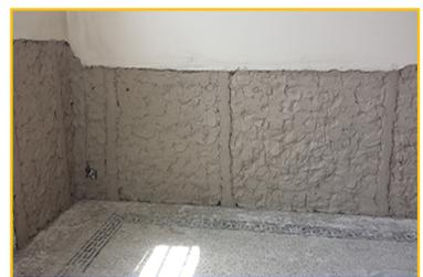
**CONSOMMATION ET RENDEMENT** CALIBRO NHL couche de fixation: 5 à 5,5 kg/m<sup>2</sup> par 0,5 cm d'épaisseur en fonction de la rugosité du support.
