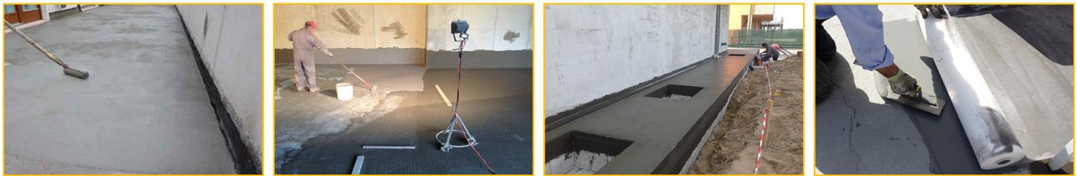
**CONSOMMATION ET RENDEMENT** 3÷3,5 kg/m<sup>2</sup> en fonction de la rugosité du support.
